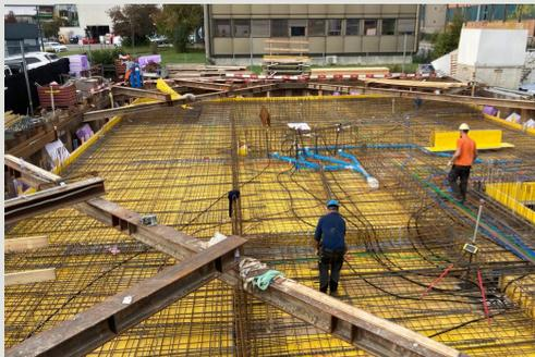
In Dietlikon entsteht ein viergeschossiges Gebäude mit einem Untergeschoss. Wegen der engen Platzverhältnisse und des wassergesättigten Bodens wurde der Baugrubenabschluss mittels einer eckgespriessten Spundwand erstellt. Die Ecksprieße mussten konfliktfrei mit der Anschlussbewehrung der aufgehenden Wände und Stützen im EG koordiniert werden. Das Ziehen der Spundwände auf der Decke UG stellte eine weitere technische und logistische Herausforderung dar.
