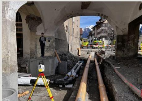
In der Vialstrasse in Zizers werden die Werkleitungen der Gemeinde im Zuge umfassender Sanierungsmassnahmen ersetzt. Dabei wird das bestehende Mischabwassersystem neu als Trennsystem ausgeführt. Weiter werden weitere Werkleitungen wie Fernwärmeleitungen, Kabelkommunikation, Telefonie und Strom erneuert und ausgebaut.
