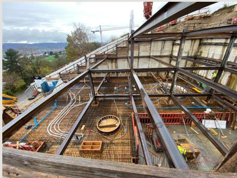
Bei der Tragstruktur handelt es sich um einen klassischen Massivbau mit Sichtbetonfassade mit Weisszementanteil. Die Hangdruckkräfte werden gezielt über Rippen unter der Bodenplatte und Mikropfählen aufgenommen und in den anstehenden Baugrund abgetragen. Es wurden diverse Abfangkonstruktionen konzipiert.
