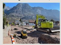
Die Bahnhofstrasse wird auf der Grundlage eines Betriebs- und Gestaltungskonzeptes umfassend saniert und neugestaltet. Die Sanierungsstrecke ist 550m lang und liegt zwischen Seezbrücke und dem Postplatz. Der Strassenoberbau wird komplett saniert und die Fussgängerübergänge werden optimiert. Weiter wird die Parkierung neu organisiert, die Entwässerung sowie die Beleuchtung erneuert und, durch die Anordnung von Bäumen beim Trottoir, die Strasse optisch aufgewertet.
