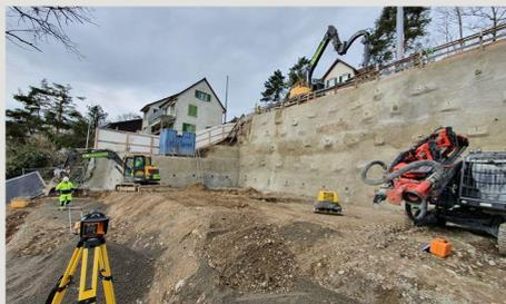
An der stark frequentierten Winzerstrasse in Zürich entsteht ein Mehrfamilienhaus mit insgesamt fünf Wohneinheiten. Die drei unteren Geschosse des fünfgeschossigen Gebäudes werden hangseitig ins Erdreich eingebunden. Die dafür notwendige und bis zu 9m tiefe Baugrube sowie die beengten Platzverhältnisse zwischen Böschungskante und der Winzerstrasse stellen dabei bautechnisch die grössten Herausforderungen dar.
