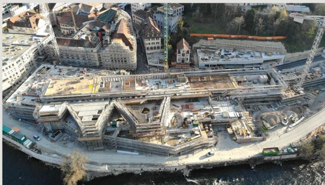
Die Stahlbetonarbeiten im Bäderquartier in Baden sind in vollem Gange. Ein beachtlicher Teil des rund 210m langen und bis zu 100m breiten Gebäudes befindet sich unter Terrain und tritt zukünftig nicht mehr in Erscheinung. Umso spektakulärer werden dagegen die vier grossen, gegen die Limmat kragenden Gebäudekuben der Badehallen wirken.
