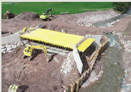
Im Zuge des Hochwasserschutzprojekt Schils wird eine neue Brücke für Schwerverkehr unterhalb des Geschiebeablagerungsplatzes notwendig. Die neue Strassenbrücke weist eine Spannweite von rund 17m auf und wird als einfeldrige Rahmenbrücke konzipiert. Die vorgespannte Stahlbetonplatte wird über Widerlager und Mikropfähle fundiert. Insgesamt werden 30'000kg Stahl und 190m Spannkabel verbaut. Als Bauhilfsmassnahme wird die Baustelle mittels Spundwänden trocken gehalten und die Schils umgeleitet.
