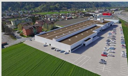
Das bestehende Produktionsgebäude der Elesta AG in Bad Ragaz wird um rund 4'000 m<sup>2</sup> erweitert. Die Tragkonstruktion besteht aus vorgefertigten Betonelementen sowie einer Dachkonstruktion aus Stahl und Blechprofilen. Die gesamte Konstruktion wird in Köcherfundamenten eingespannt und mit einer nachträglich erstellten Bodenplatte sowie Querriegeln in Ortbeton ergänzt. Vorgängig musste der Baugrund grossflächig stabilisiert werden.
