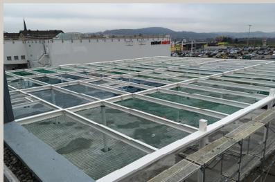
Das bestehende, teils viergeschossige Verkaufsgebäude Coop Bau + Hobby in Rickenbach wird lokal zurückgebaut und erweitert. Die neuen Verkaufsflächen werden in Stahlbauweise und teils mit Holzrahmenbauelementen erstellt und auf Stahlbetonplatten fundiert. Das Gartencenter wird komplett verglast.
