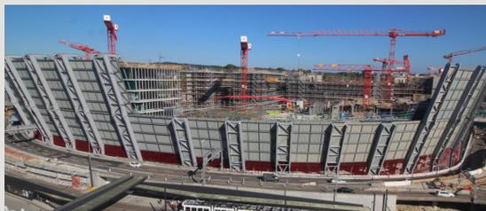
Die Rohbauarbeiten beim Grossprojekt Circle sind bereits weit fortgeschritten. Die auf Grossbohrpfählen fundierte Tragstruktur wurde als Skelettbau konzipiert. Vorwiegend schlaif armierte Flachdecken mit Regelspannweiten von 8.1m liegen auf ca. 15'500 Betonstützen auf. Nebst horizontaler Vorspannungen kommen zur
