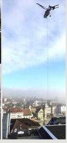
Beim Geschäftshaus Flora, mitten in der Stadt Luzern, sind wir mit der statischen Begleitung bei der Erneuerung von haustechnischen Anlagen betraut. Die geringe Tragfähigkeit des bestehenden Daches erfordert für die Platzierung der Rückkühlanlagen einen Trägerrost, welcher die Lasten auf tragfähige Wände überleitet. Nach der Vormontage des Stahlträgerrostes wurden die Rückkühler mit dem Helikopter innert 15 Minuten millimetergenau auf die Stahlkonstruktion versetzt.
