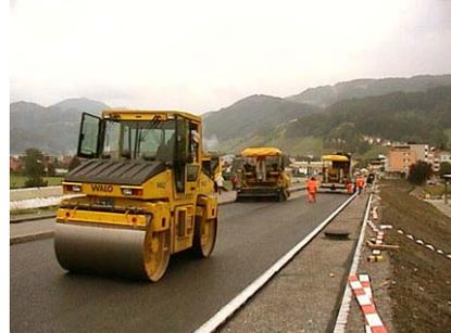
Die Zollstrasse wird auf 370m Länge auf drei Spuren ausgebaut und beidseitig mit Radstreifen und Gehweg versehen. Diese Massnahme dient der Staureduktion und verbessert die Situation für Fussgänger und Radfahrer. Unter anderem ist die Verbreiterung des bestehenden Dammes und eine Anpassung der Überführung Nollenhornstrasse notwendig.
