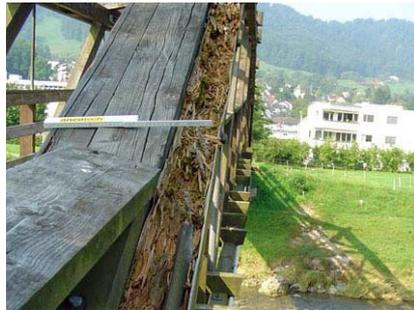
Nach zwanzig Jahren Nutzung und geringem Unterhalt sind an gewissen Bauteilen Vermorschungen festzustellen. Diese Bauteile sowie der Belag (Verschleisschicht) sind wieder instandzusetzen. Unser Ingenieurbüro hat den Auftrag erhalten, eine Zustandsanalyse zu erstellen und aufgrund dessen ein Sanierungsprojekt zu erarbeiten. Um eine lange Lebensdauer des Tragwerkes zu gewährleisten wird abschliessend ein Unterhaltsplan angefertigt.
