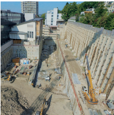
Baugrube ETH GLC, Zürich
